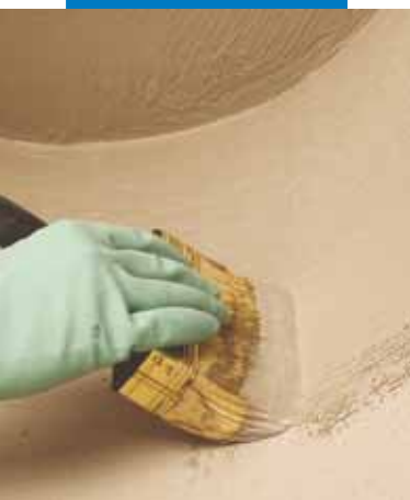
Impermeabilización de muro de cimentación a brocha
