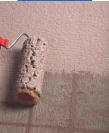
Impermeabilización de muro de cimentación a rodillo
